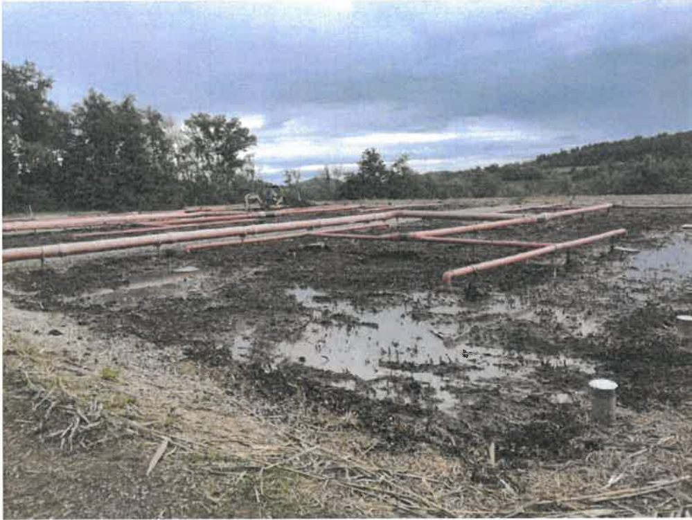
1 er étage des lits plantés de roseaux après curage
